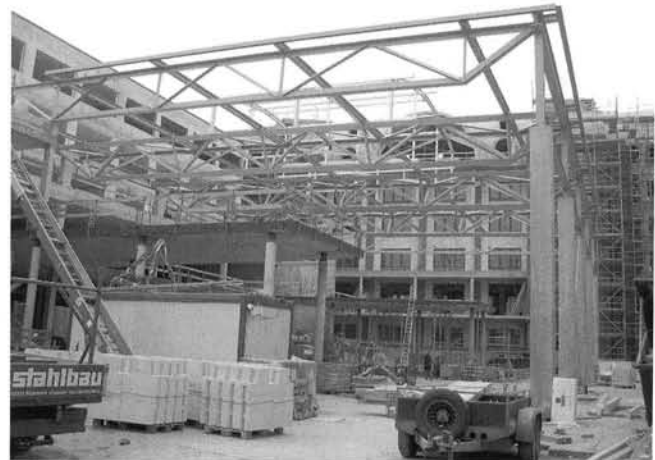
Abb. 1: Komplexe Bauabläufe erfordern eine gute Sicherheits-Koordination
