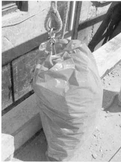
Abb. 8 und 9: Mängel im Kranbetrieb: Plastiksack als Lastaufnahmemittel (links); Rundstahlpakete aufgehängt an Drahtschlaufen.
