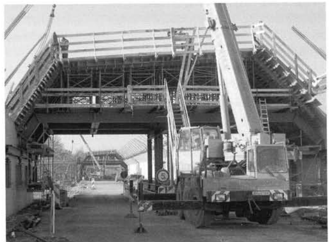
Abb. 5: Durchdachte Absturzsicherungen an Arbeitsplätzen und Verkehrswegen.
