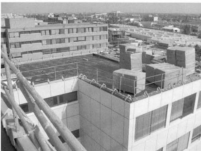
Abb. 7: Dachsanierung: Auch bei Instandhaltungsarbeiten müssen sicherheitstechnische Maßnahmen geplant werden.
