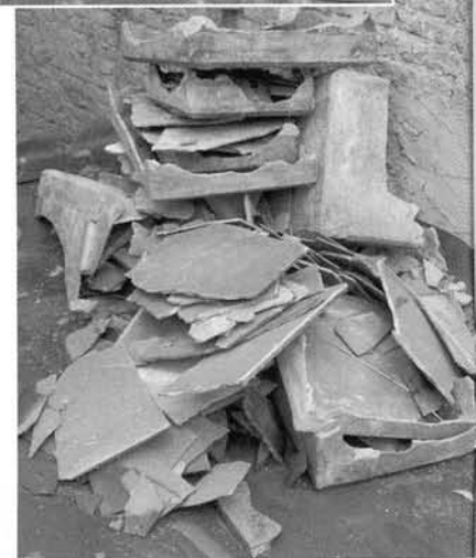
Abb. 10 und 11: Wenn Fachleute zu spät gerufen werden: unsachgemäße Gefahrstoff-Sanierung.
