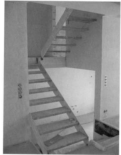
Abb. 12: Koordination muss auch Lösungen für den Endausbau anbieten: fehlende Geländer an Treppenläufen.
